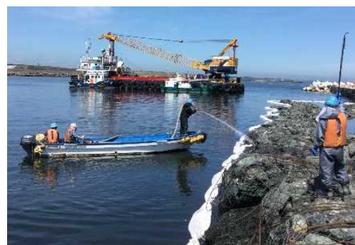
▲埋浚 護岸に付着した油の回収作業
