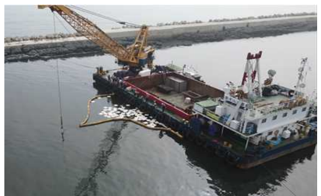
▲埋浚 吸着マットによる油の回収作業
