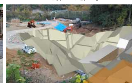
【掘削・床掘AR】
