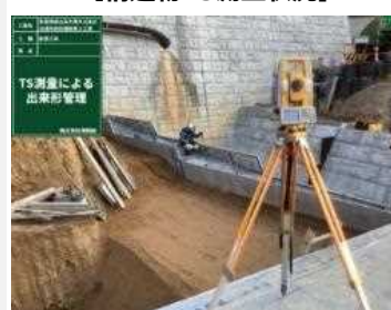
【構造物TS測量状況】
