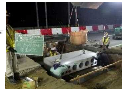
今回取組施工状況写真
