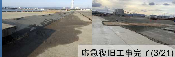
3号ふ頭岸壁(-12m、耐震)
