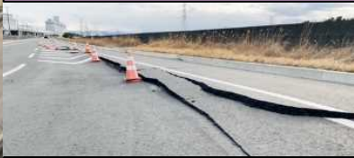
臨港道路5号ふ頭内線
