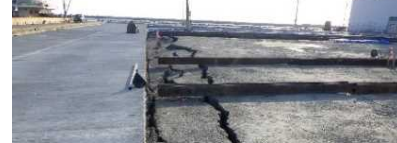
1号ふ頭6,7,8号岸壁
