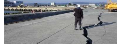
2号ふ頭1号岸壁
