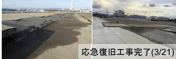
3号ふ頭岸壁 (-12m、耐震)
