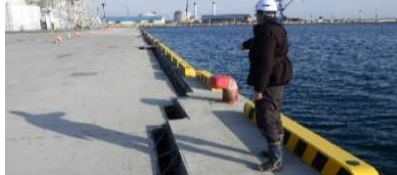
1号ふ頭1,2,3,4,5号岸壁
