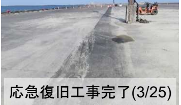
2号ふ頭4号岸壁
