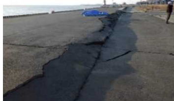
5号ふ頭4号岸壁
