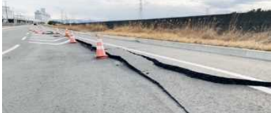
臨港道路5号ふ頭内線
