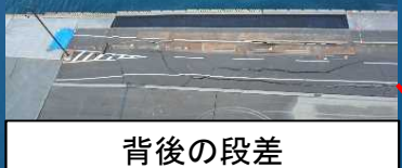
3号ふ頭護岸、ふ頭用地
