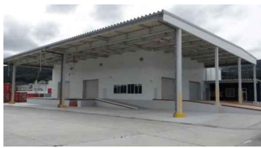
大船渡港に完成したコンテナ用上屋倉庫(H29.10撮影)
