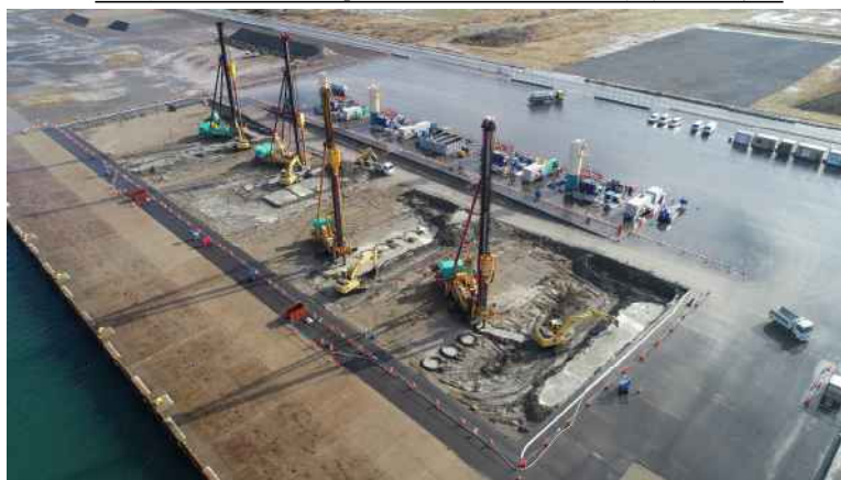
整備が進む飯島地区岸壁(-11m)改良(耐震)
