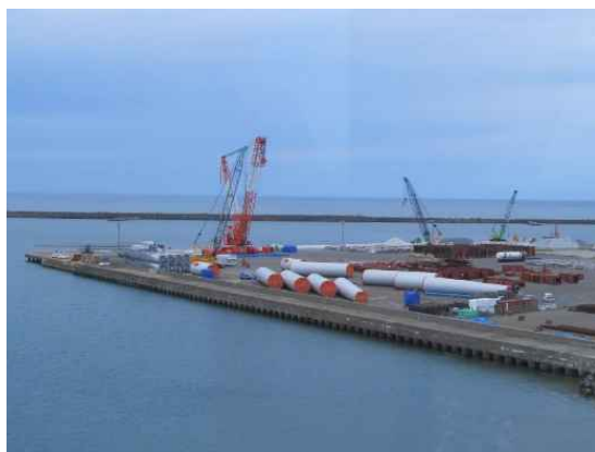
能代港に荷揚された陸上風力発電の風車部品(大森-13m岸壁)
