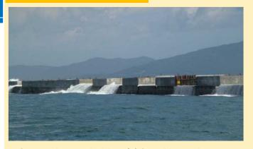
復旧工事中の防波堤(南)を越える波 →嵩上げ未施工区間から頻繁に波が越えてくるため、港内における航行船舶の安全や荷役作業に 悪影響を及ぼしていました。
