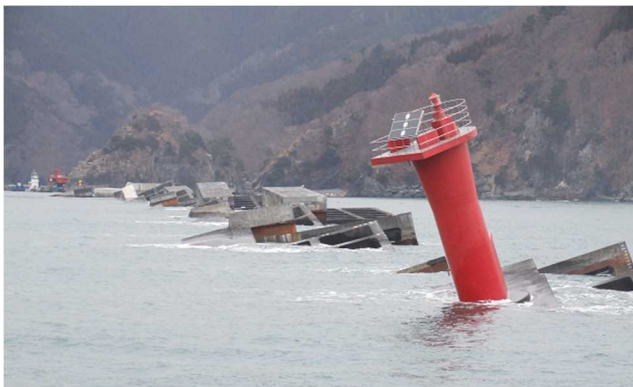
防波堤が倒壊(釜石港)
