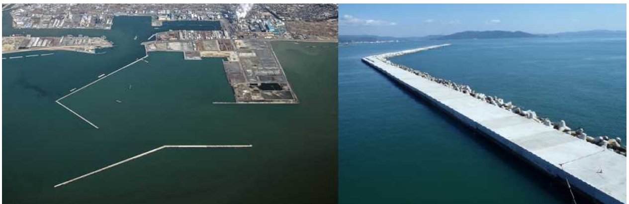
防波堤整備が進む仙台塩釜港石巻港区
