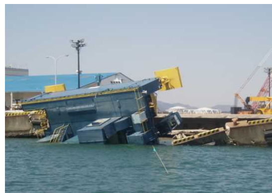
荷役機械が転倒・水没(相馬港)
