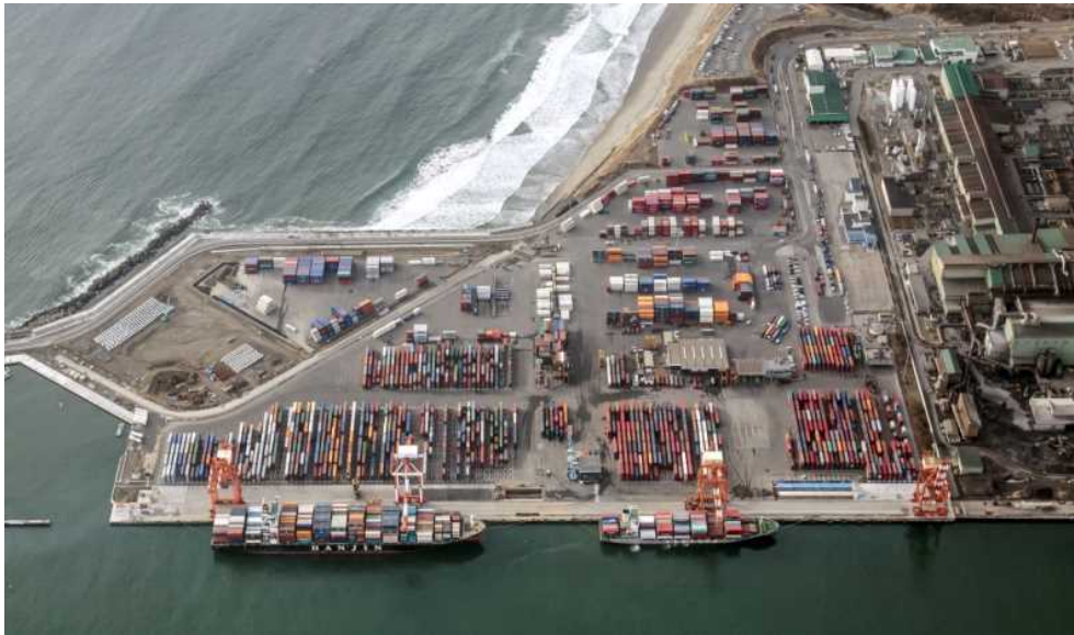
拡張整備が進められている仙台塩釜港高砂コンテナターミナル
