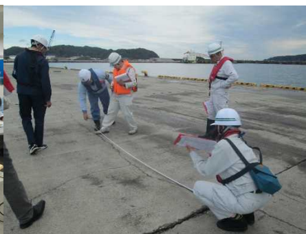
【点検診断実習状況】
