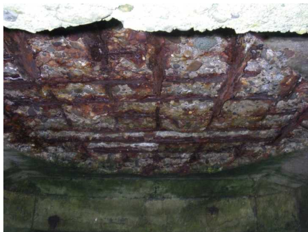
栈橋床版下面鉄筋露出(50年経過) 腐食による 鋼矢板開孔(44年経過) 上部工欠損(37年経過)
