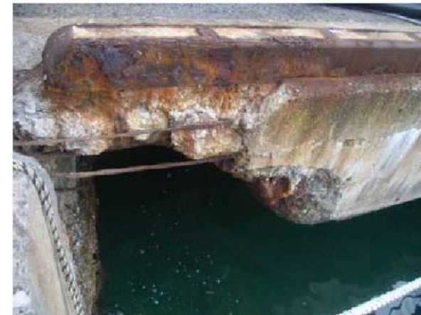
栈橋床版下面鉄筋露出(50年経過) 腐食による 鋼矢板開孔(44年経過) 上部工欠損(37年経過)
