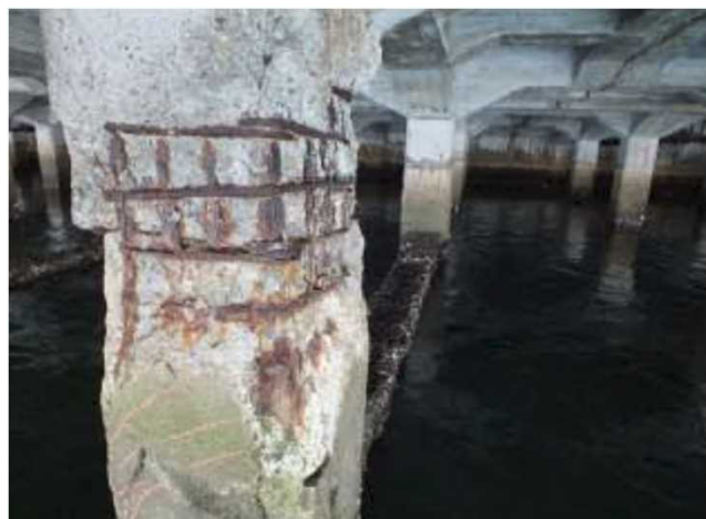
栈橋脚柱部鉄筋露出(48年経過) エプロンひび割れ、剥離(34年経過) 上部工割れ(43年経過)
