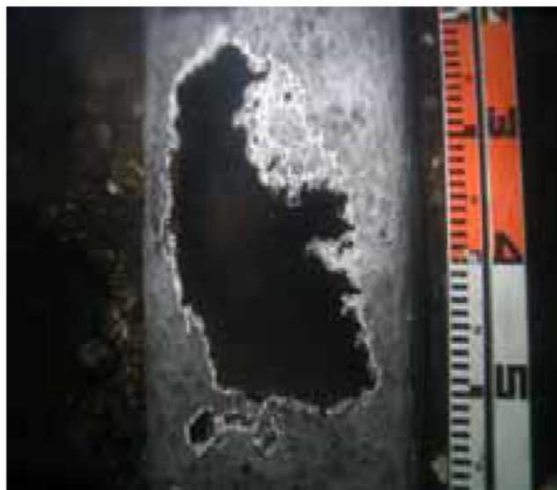
栈橋床版下面鉄筋露出(50年経過) 腐食による 鋼矢板開孔(44年経過) 上部工欠損(37年経過)
