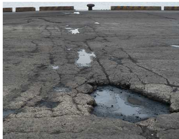
栈橋脚柱部鉄筋露出(48年経過) エプロンひび割れ、剥離(34年経過) 上部工割れ(43年経過)
