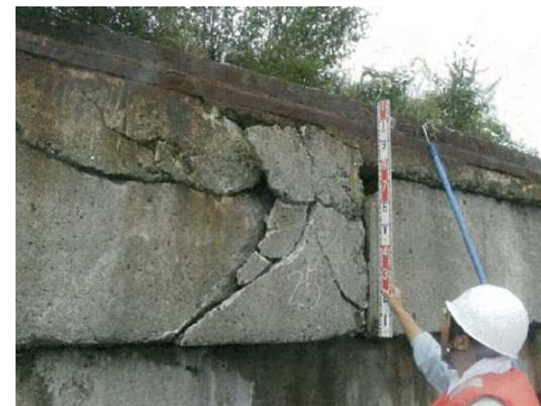
栈橋脚柱部鉄筋露出(48年経過) エプロンひび割れ、剥離(34年経過) 上部工割れ(43年経過)
