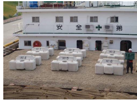
図 2. 左:ストーンブロック(凸型 4t)、右:起重機船積み込み状況
