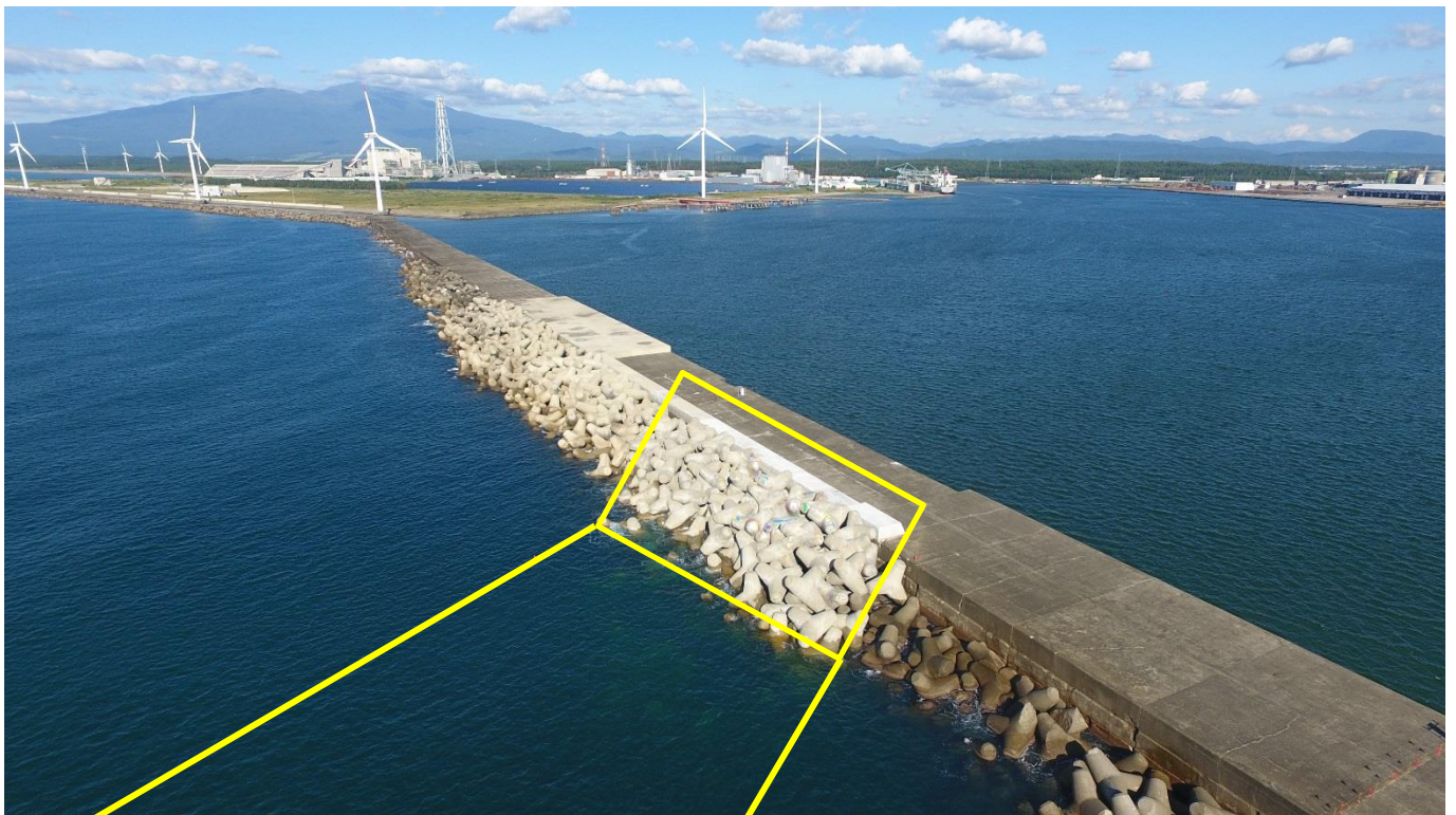
消波ブロックが据え付けられた酒田港北防波堤
