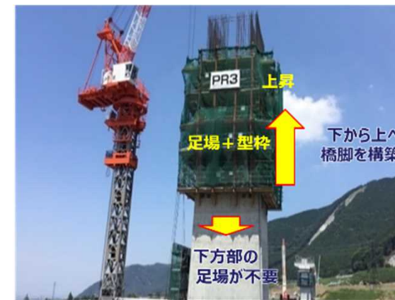
ACSセルフクライミングシステム工法
