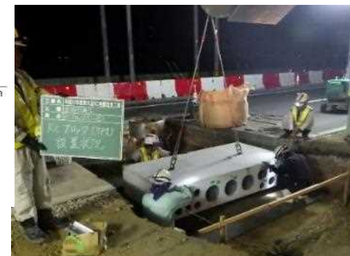
今回取組施工状況写真
