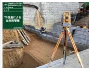
【構造物TS測量状況】
