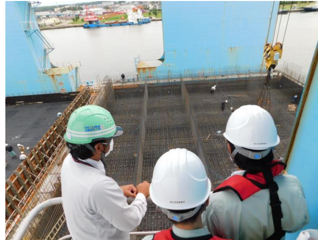
ケーソン製作現場見学の様子
