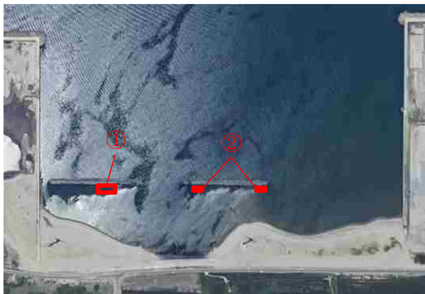
・大浜海岸コンクリートブロック設置位置
