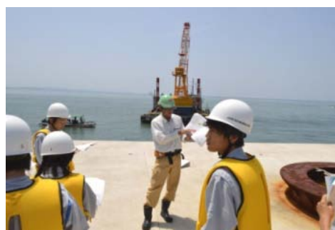
▲防波堤工事の現場を見学
