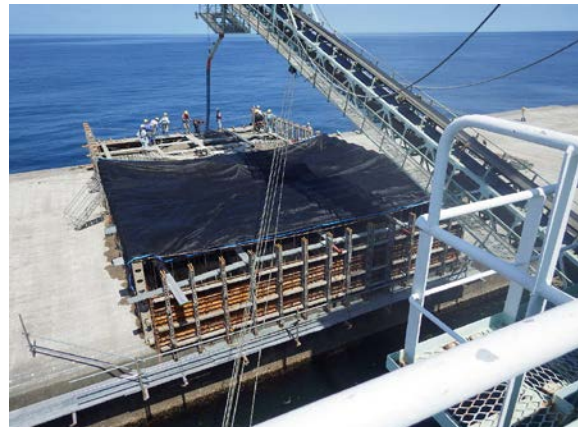
第2北防波堤 上部嵩上げ工事
