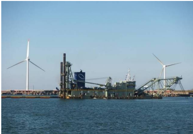
泊地(-13m)外 ポンプ浚渫工事
