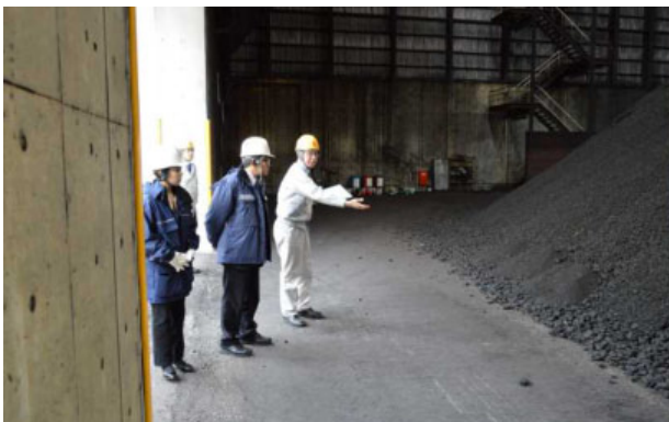
酒田共同火力発電所（貯炭場）
