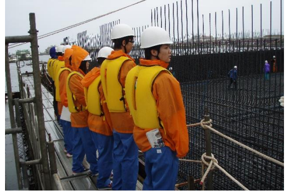
ケーソン製作現場の見学
