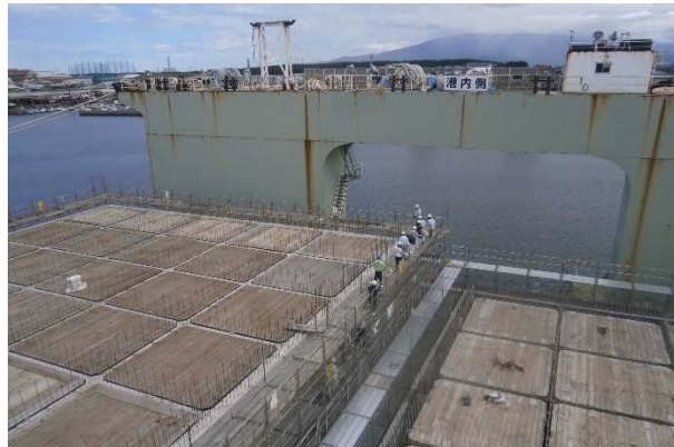
足場から製作中のケーソンを見学
