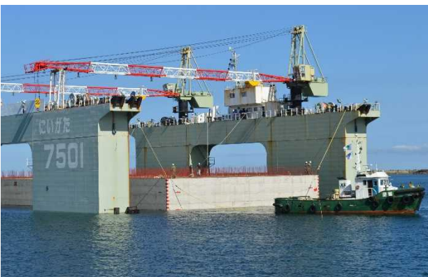
ケーソンの引き出し
