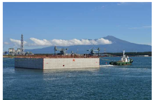
曳航されるケーソン
