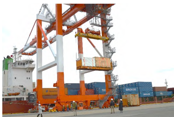
コンテナ荷役状況
