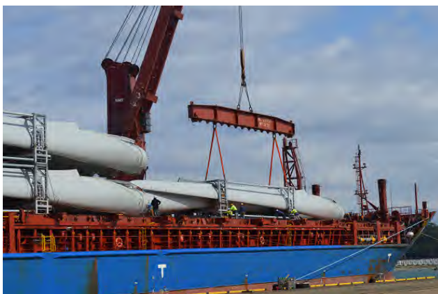
ブレードの荷役状況
