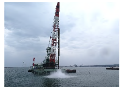
起重機船からジェット水を 噴射している様子
