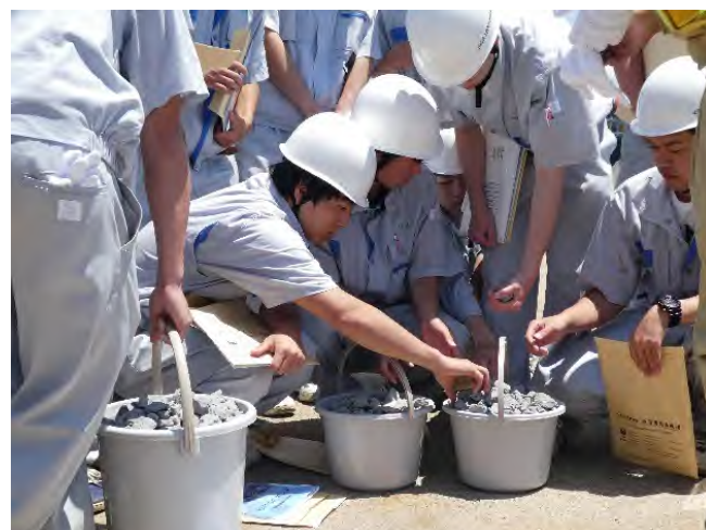
護岸築造現場では目で見て触って持ち上げて！
