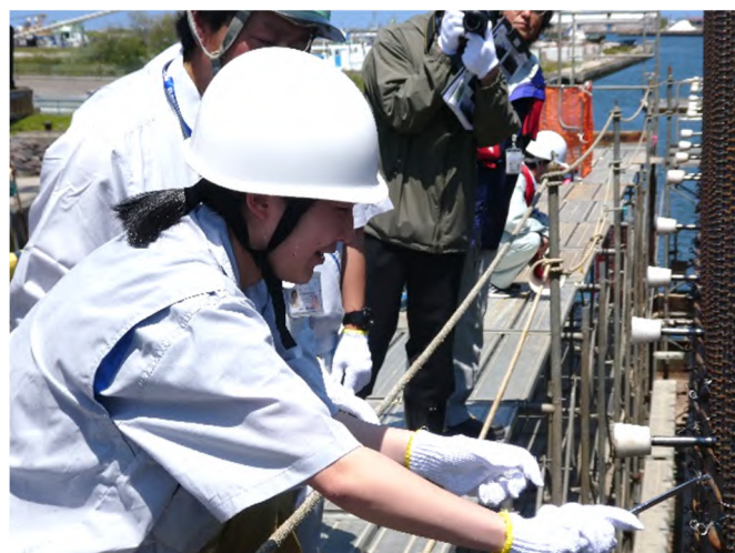
ケーソン製作現場では鉄筋結束を体験
