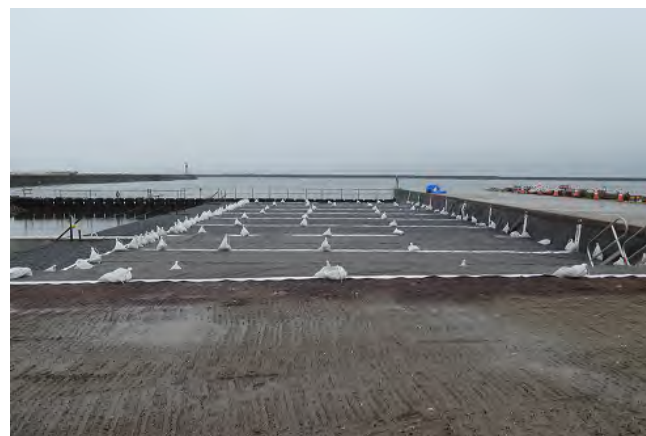
岸壁延伸工事状況
