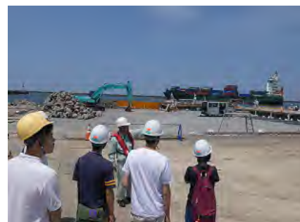
高砂岸壁延伸工事の現場を見学
