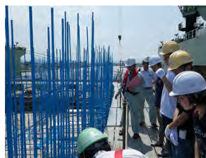
ケーソン製作現場を見学
