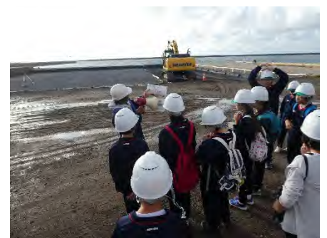
高砂岸壁延伸工事の説明
