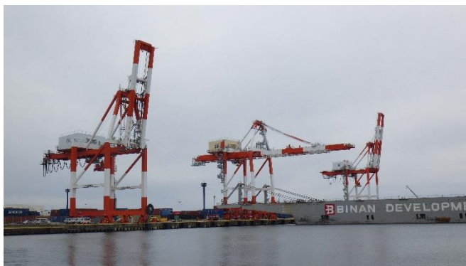
4/10、ガントリークレーン専用運搬船から岸壁へ据付
