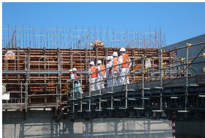
ケーソンの製作現場を間近で見学
