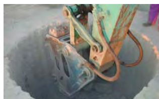
④大型ブレイカーによる小割 B.H.0.7m 3 級
