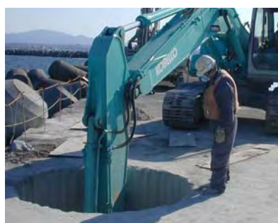
②大型ブレイカーによる小割 B.H.0.7m 3 級
