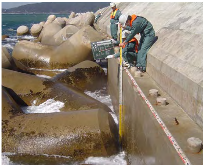
写真一資.3.1 接点 NO.15 測定状況
