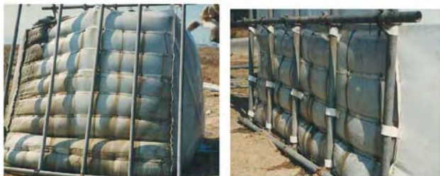
補強ベルトをつけたコンクリートバッグの例
