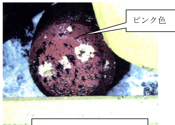
写真-2.5.1 消波ブロック
