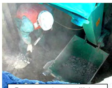
③バックホウによる撤去 人力併用, B.H.0.25m 3 級
