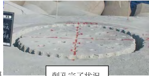
削孔完了状況
