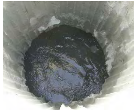
③蓋コンクリート破砕完了
