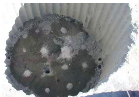
①静的破碎材充てん(青丸部)
