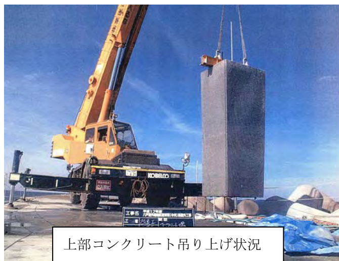
写真-5.2.2 撤去状況
