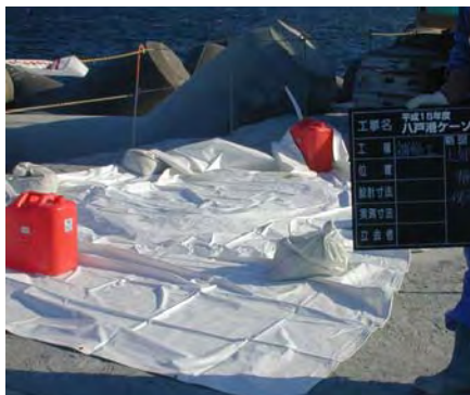
②静的破砕材充てん後、注水し、直ちにシート養生
