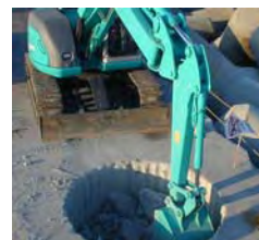
⑤バックホウによる撤去 B.H.0.25m 3 級
