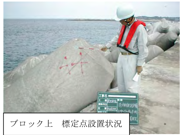
標定点設置状況
