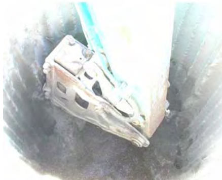
②大型ブレーカーによる破砕 0.7m 3 級バックホウ
