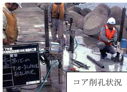
写真-5.2.3 削孔状況
