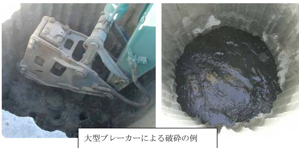
写真-5.2.5 蓋コンクリート撤去
