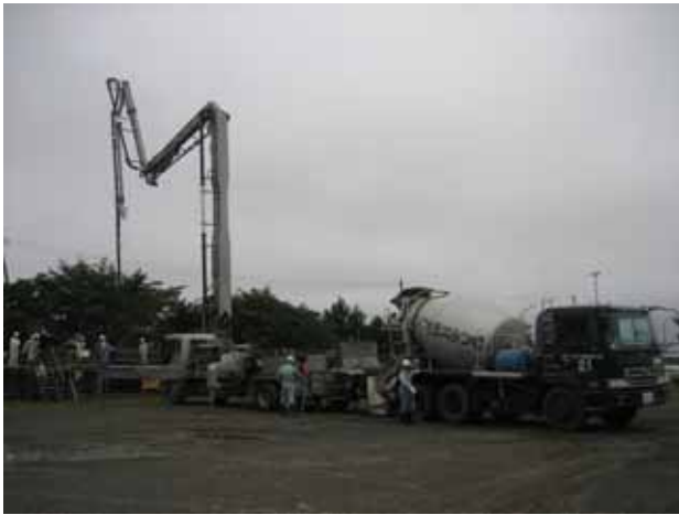
写真 4-11 シェルコンクリート打設状況(1リフト)
