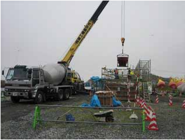
写真 4-1 シェルコンクリートの打設状況
