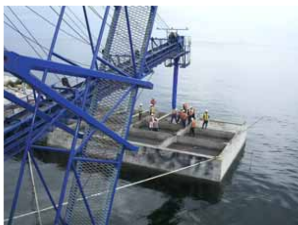
写真 4-8 シェルコンクリートの打設状況
