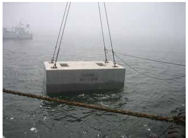
写真 4-6 根固ブロック海中投入状況
