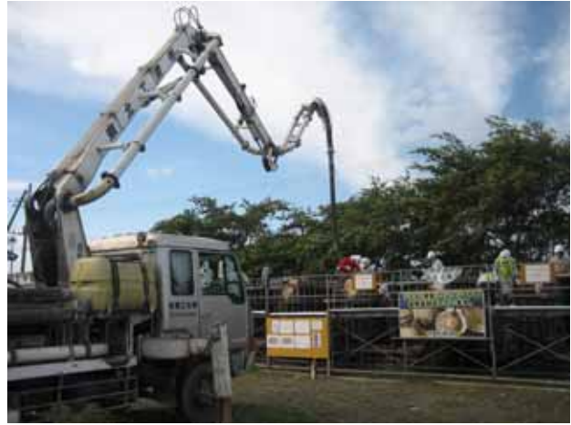
写真 4-12 シェルコンクリート打設状況(2リフト)
