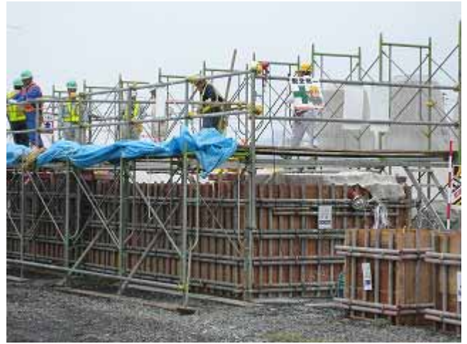
写真 4-2 シェルコンクリートの打設状況
