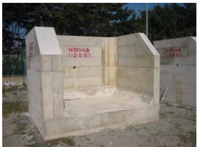
写真 4-16 ケーソン模擬供試体全景
