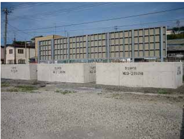
写真 4-5 根固ブロック全景
