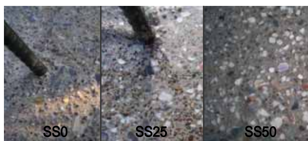
写真4-10 レイタンス処理後の打継ぎ部
