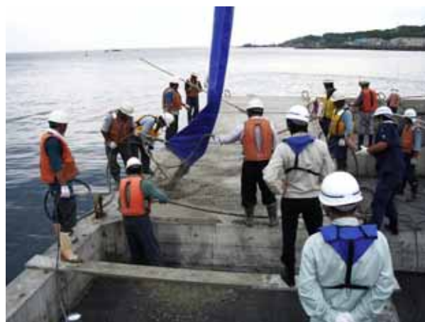
写真 4-9 シェルコンクリートの打設状況 (SS25%)
