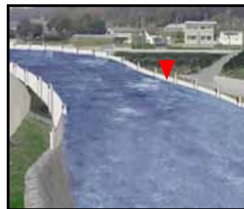
〔河川の増水氾濫対策に〕
