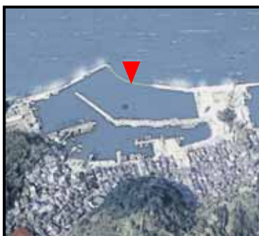
〔防波堤開口部の締切に〕
