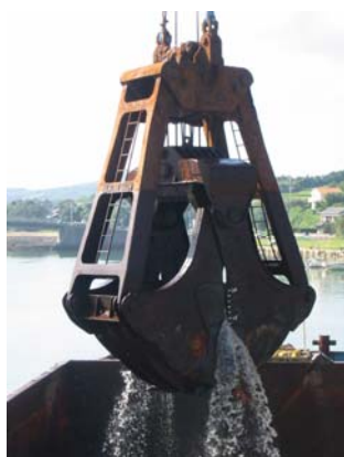
通常密閉バケットによる泥掴み状況
