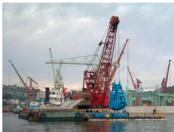
浚渫状況全景
