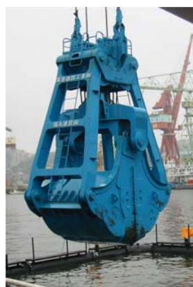
スーパーグラブバケットによる泥掴み状況
