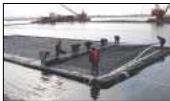
写真-5 生分解性シート敷設状況
