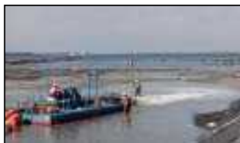
写真-6 水搬工法による覆砂
