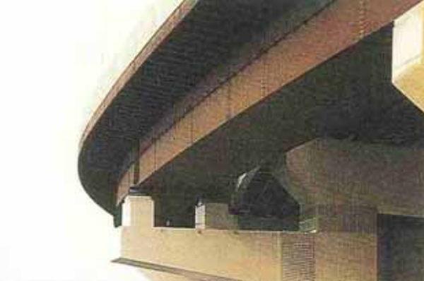
1983年1月撮影(竣工1年1ヶ月後)
