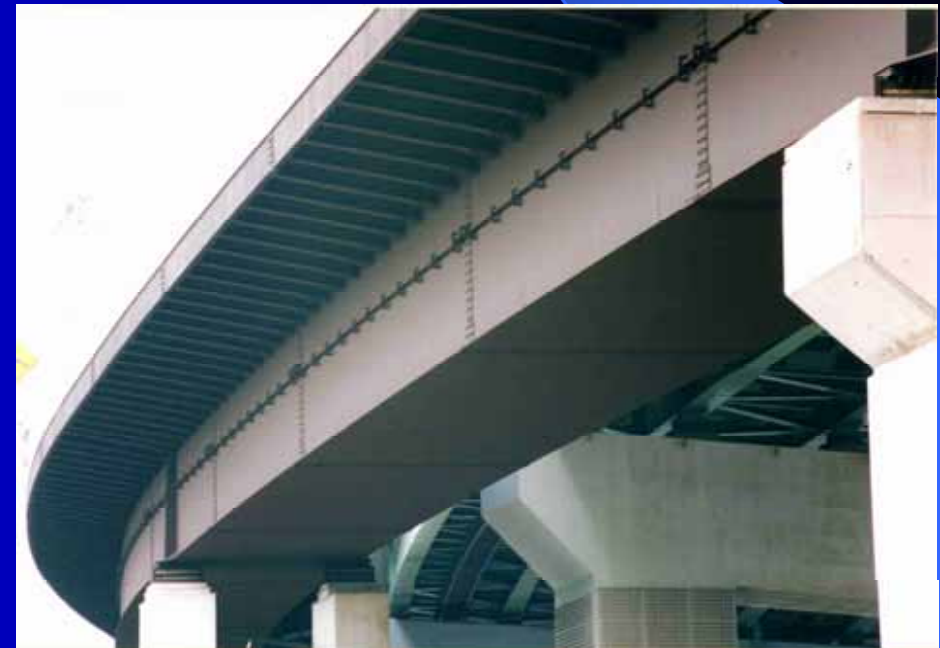
2004年6月撮影(竣工22年6ヶ月後)
