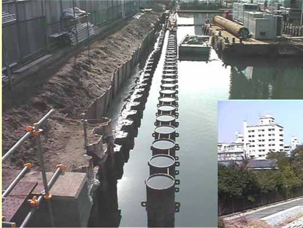
東京都 大横川の改良事例 (鋼管矢板自立式)
