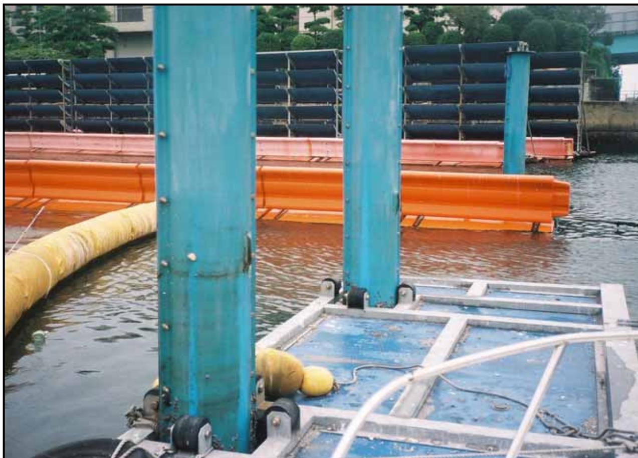
図 耐衝撃仕様FRP保護カバーを用いた現地防食工法の係留杭への適用例
