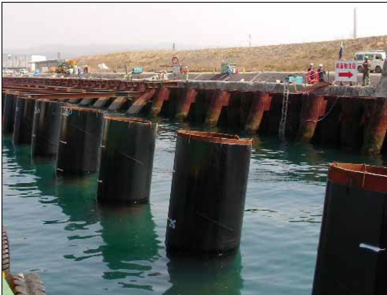
図 ポリウレタン被覆鋼材の適用例(徳山下松港新南陽地区岸壁)
