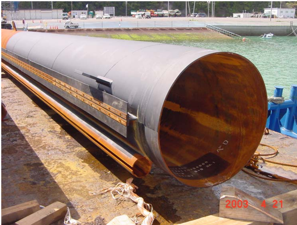
鋼管矢板本体
