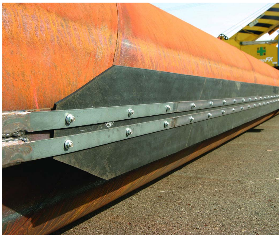
漏洩防止板ゴム下端部
