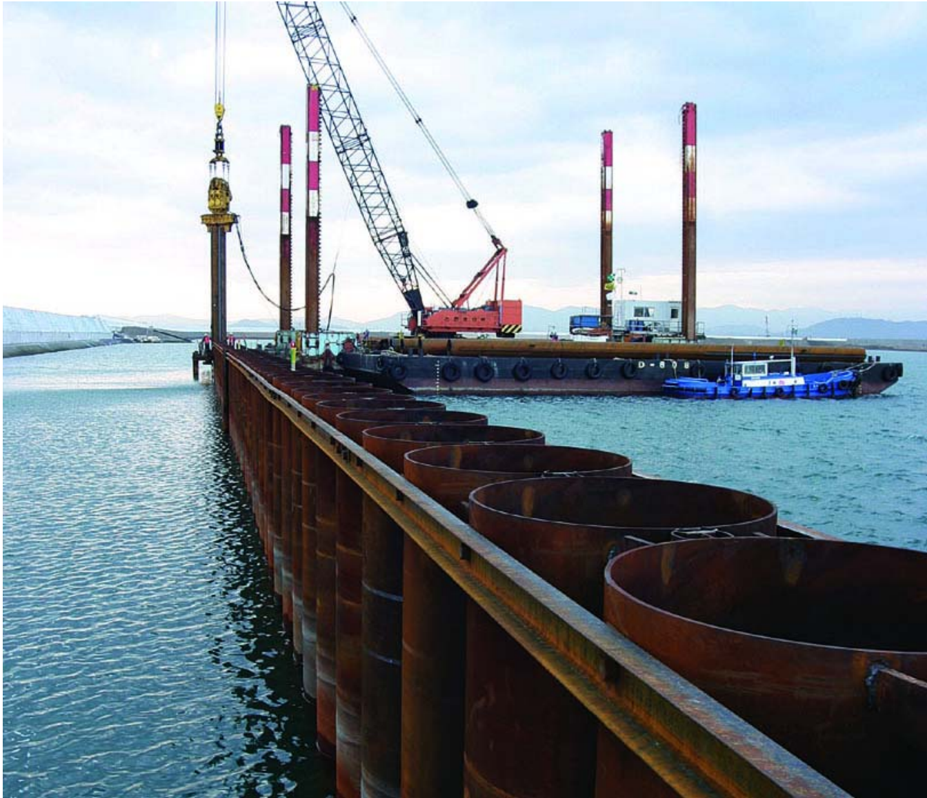
打設状況(本間工区)
