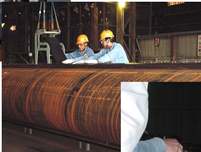
漏洩防止板ゴム等取り付け
