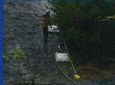
吹き付け法面における地盤構造探査
