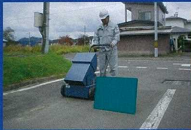
路面下空洞調査
