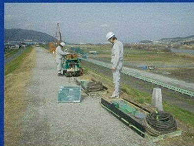
河川堤防における堤体構造調査
