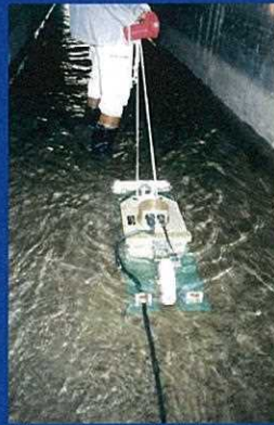
水路(樋管)内空洞調査
