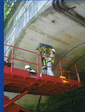
トンネル空洞調査
