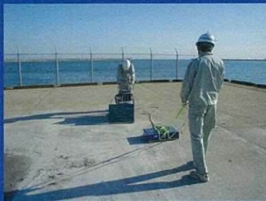
港湾施設内空洞調査
