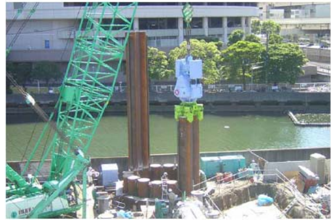
連結鋼管矢板打設状況
