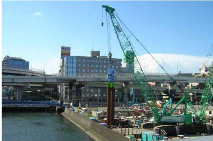
連結鋼管矢板打設状況(200tクローラークレーン使用)
