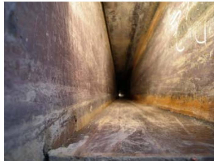
継手嵌合部 [H350-H250] (排泥処理後)
