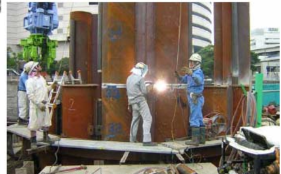
連結鋼管矢板接合状況（半自動溶接）
