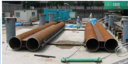
連結鋼管矢板打設状況(200tクローラークレーン使用)
