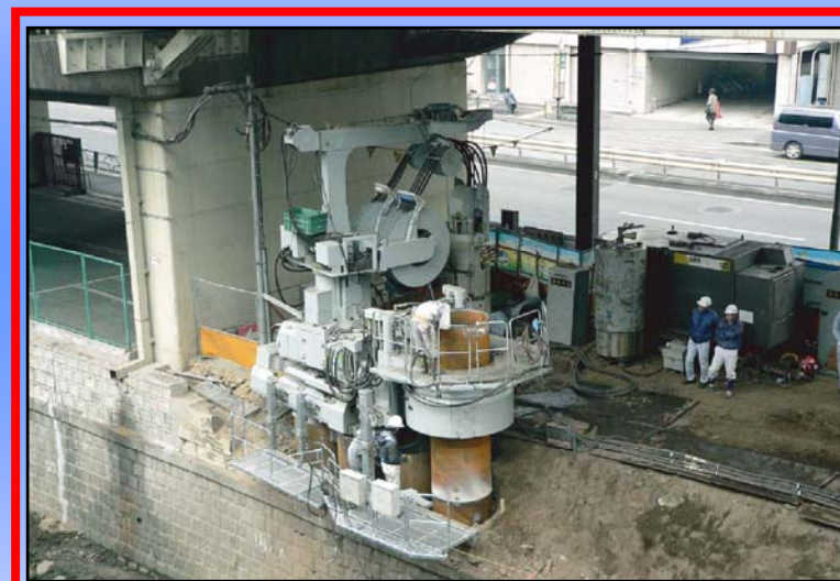
ジャイロパイラーによる既設護岸貫通
