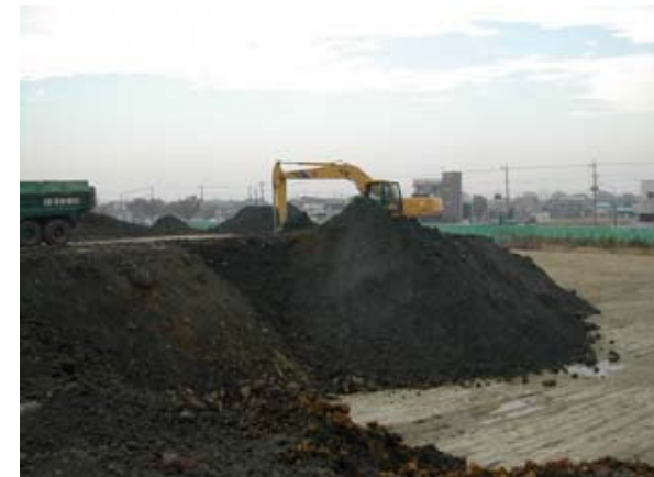
写真-2 宅地盛立て状況
