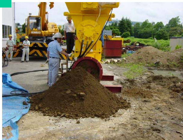
土砂搬送実験
