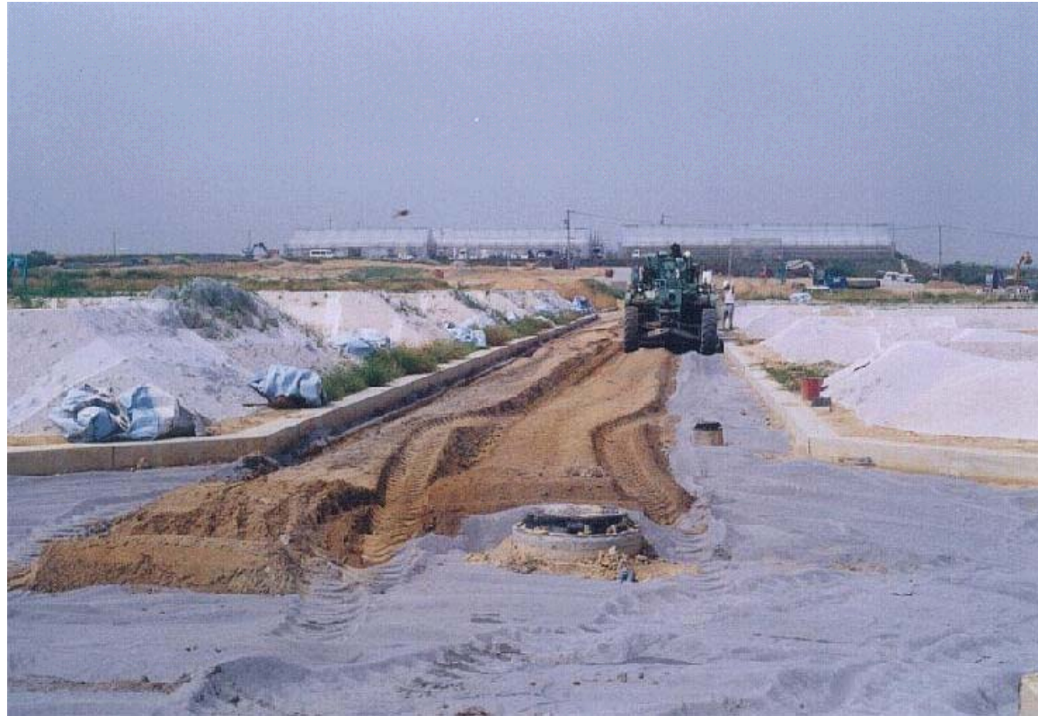
浅層改良工法による路床材の改良
