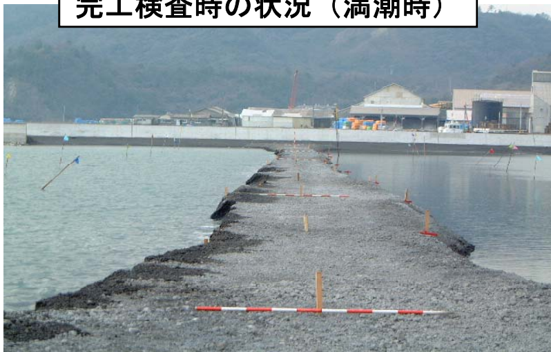
完工検査時の状況（満潮時）
