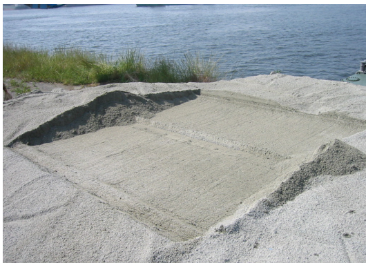
写真-5 水平掘削の掘削面
