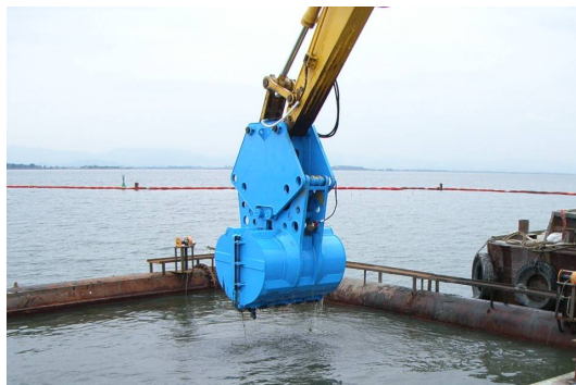
写真-3 S G B 浚渫工法（水切り時）
