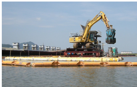
写真-7 百間川の浚渫状況
