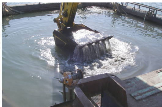
写真-4 バックホウ浚渫工法
