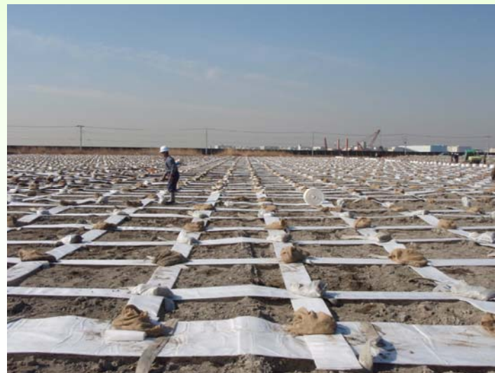
4. 施工後 (布設後覆土)
