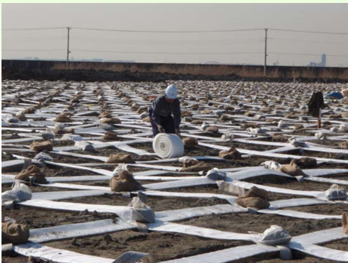
3. BSBドレーンの布設
