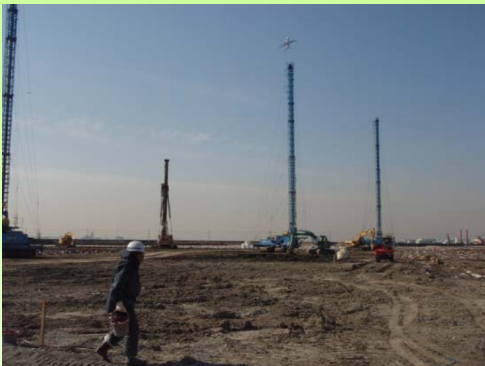
1. 施工前 (敷網・整地・先行削孔)
