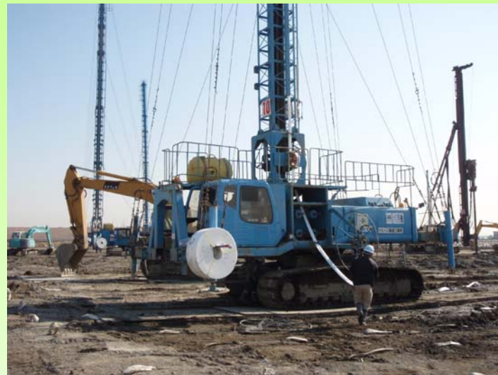
2. ノーナルドレーンの打設
