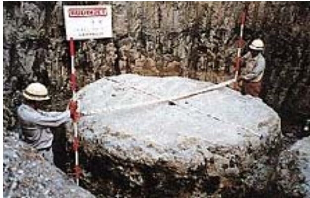
【改良体写真(円柱状の改良体)】
