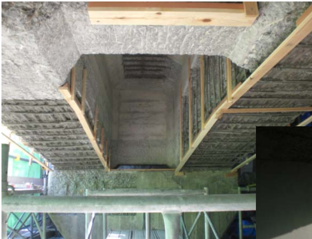
断面修復状況(はつり後)
