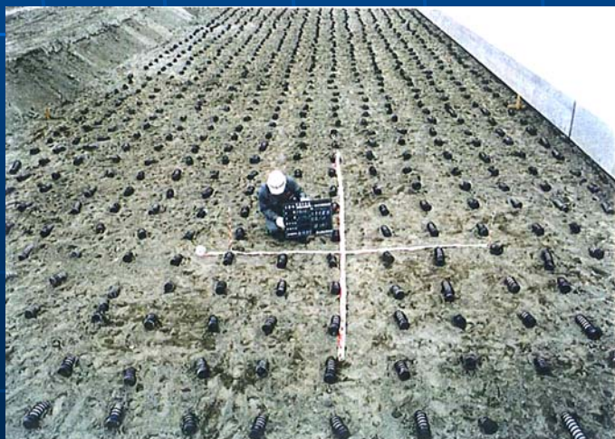
スパイラルドレン施工状況(b)
