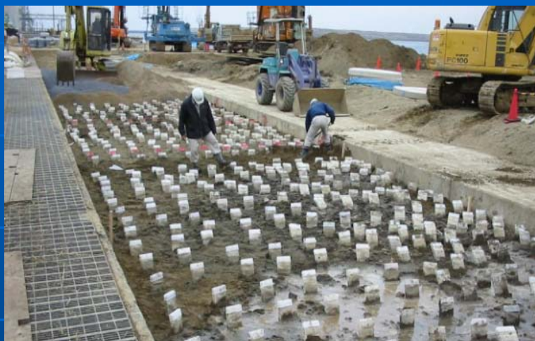
グリッドドレン施工状況
