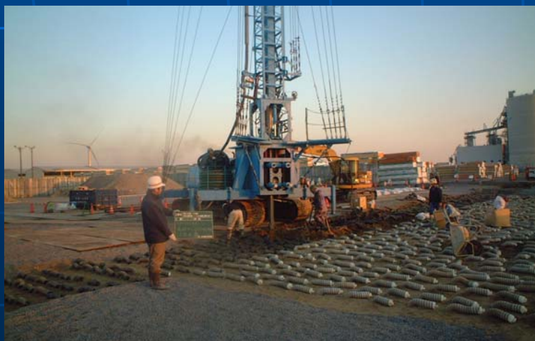
スパイラルドレン施工状況
