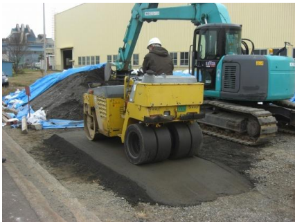
ローラー転圧状況
