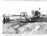
津波堆積土に改良土を適用した岸壁かさ上げ工事の試験施工
