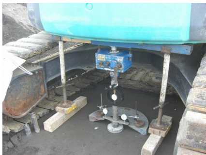
現場CBR試験状況
