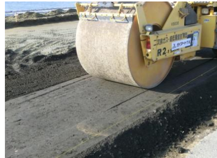
ローラー転圧状況
