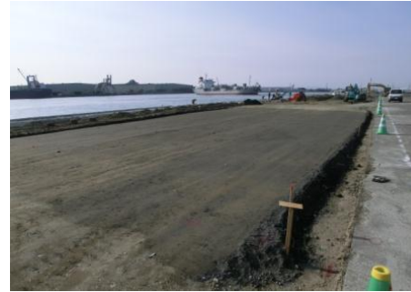
路床完成状況
