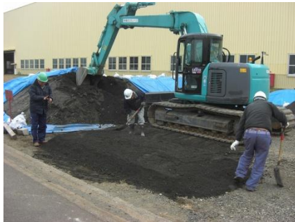
盛土作成状況
