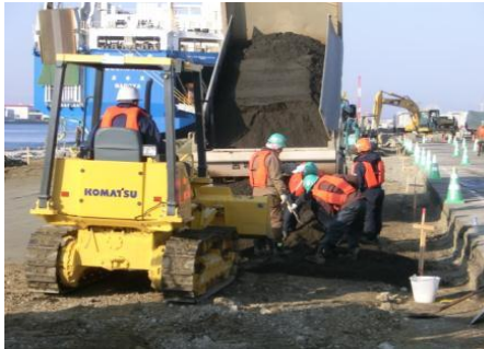
改質土運搬状況
