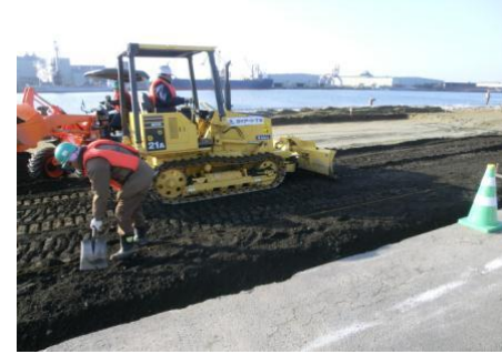
敷き均し状況
