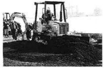
岸壁のかさ上げ工事に使われた改質土をならす作業員（19日）
