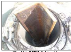
アンクルの建込み(セット)
